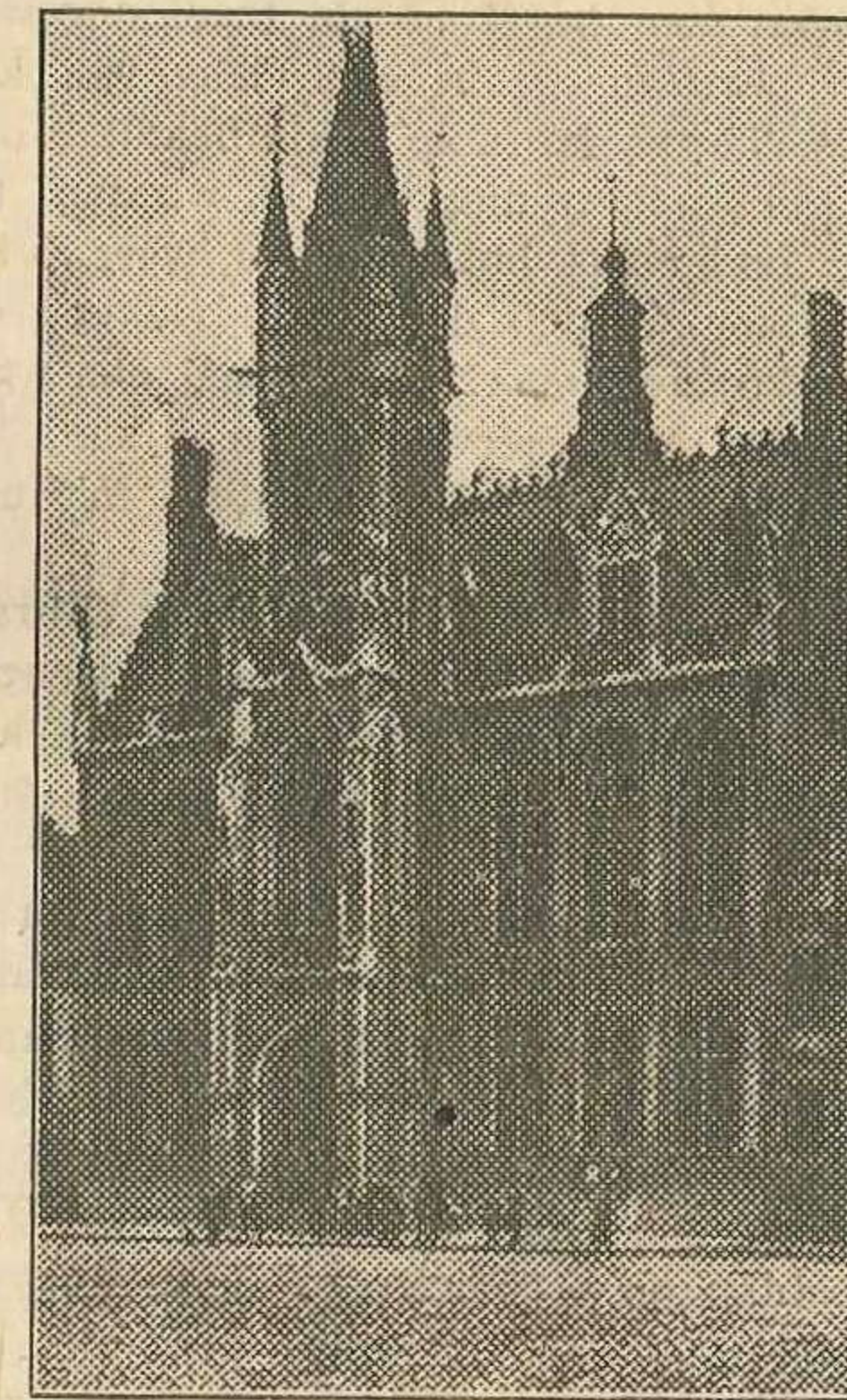
Het Stadhuis te Dixmuiden
